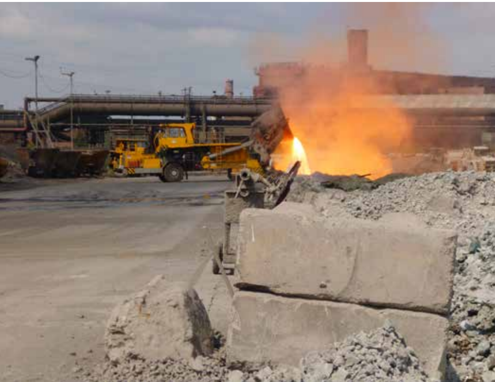
■ Hohe Lasten von über 200 t und Belastungen durch Hitze verlangen nach gilsonitemodifizierten Spezialbelägen. Stahlwerk Thyssen Krupp Mannesmann in Duisburg.
